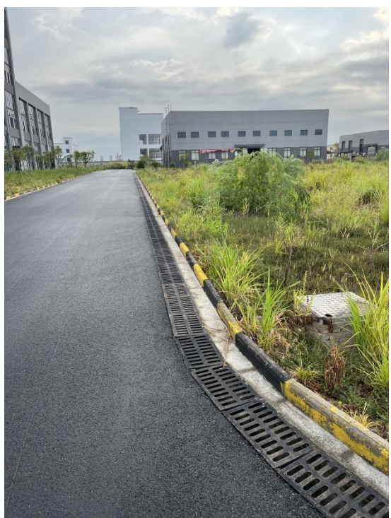
道路旁的雨水管网
